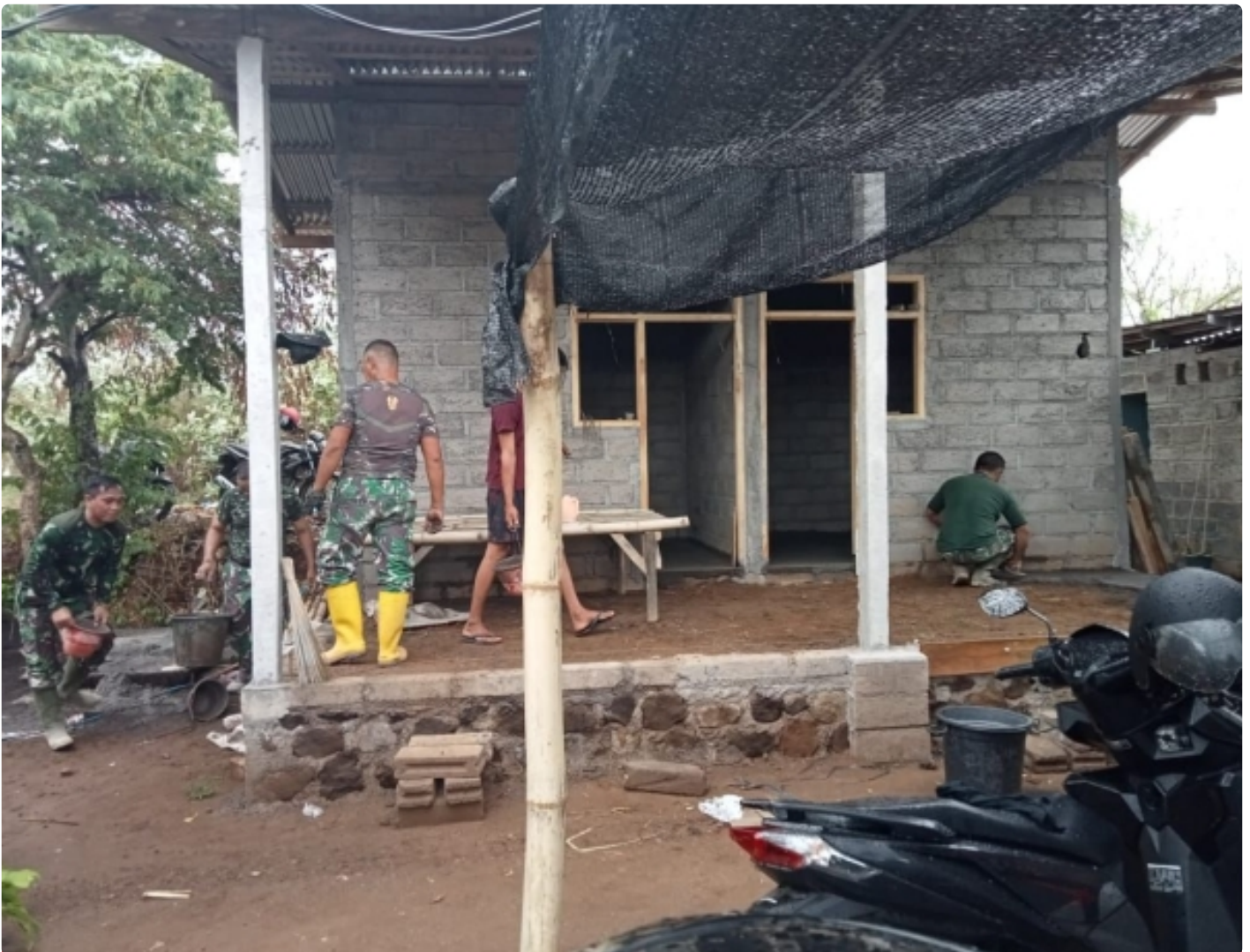
Progres TMMMD ke - 115 pada hari ke - 7
